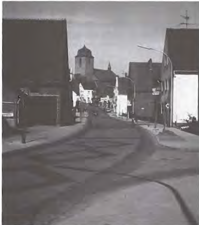
Bild 7: Betonsteinpflaster, Bundesstraße 241, Borgentreich
