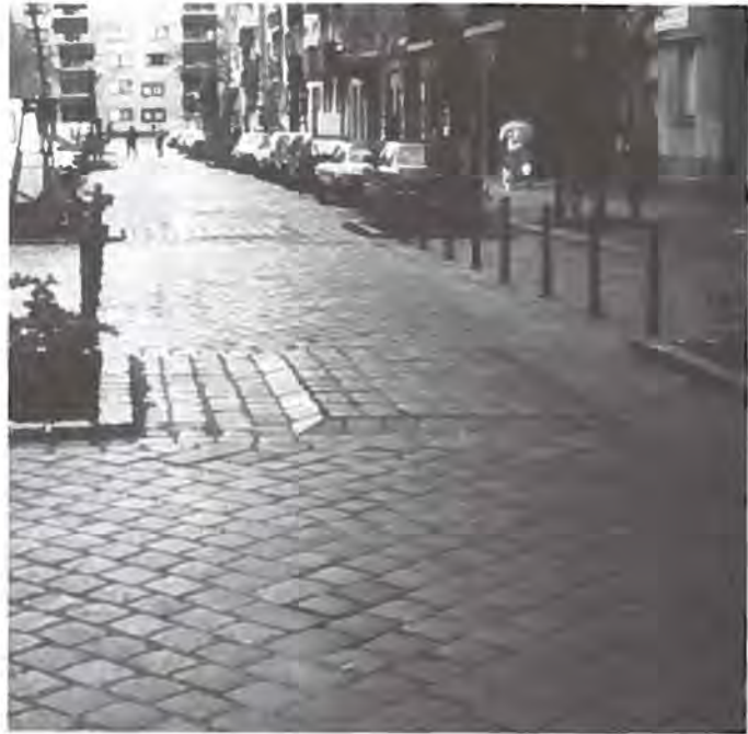
Bild 8: Plateaupflaster zur Verkehrsberuhigung, Berlin-Moabit
