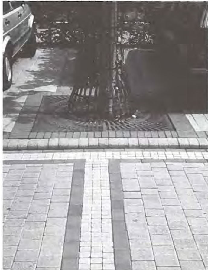
Bild 6: Betonsteinpflaster in Köln, Sanierung Stollwerk
