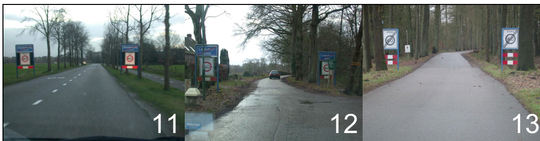
Afbeelding 4.6. Voorbeelden van een sobere uitvoering van een poort bij zoneovergangen in Leusden (foto 11 tevens onjuiste asmarkering.)
