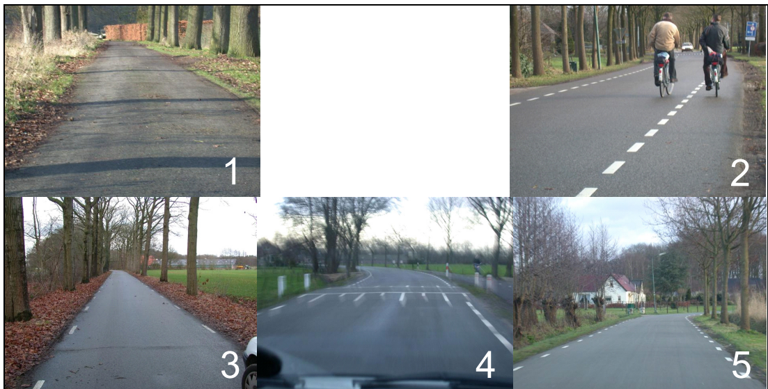
Afbeelding 4.3. Voorbeelden van een juiste markering (foto's 1-2) en onjuist uitgevoerde markering (foto's 3-5) van erftoegangswegen buiten de bebouwde kom in Leusden.
