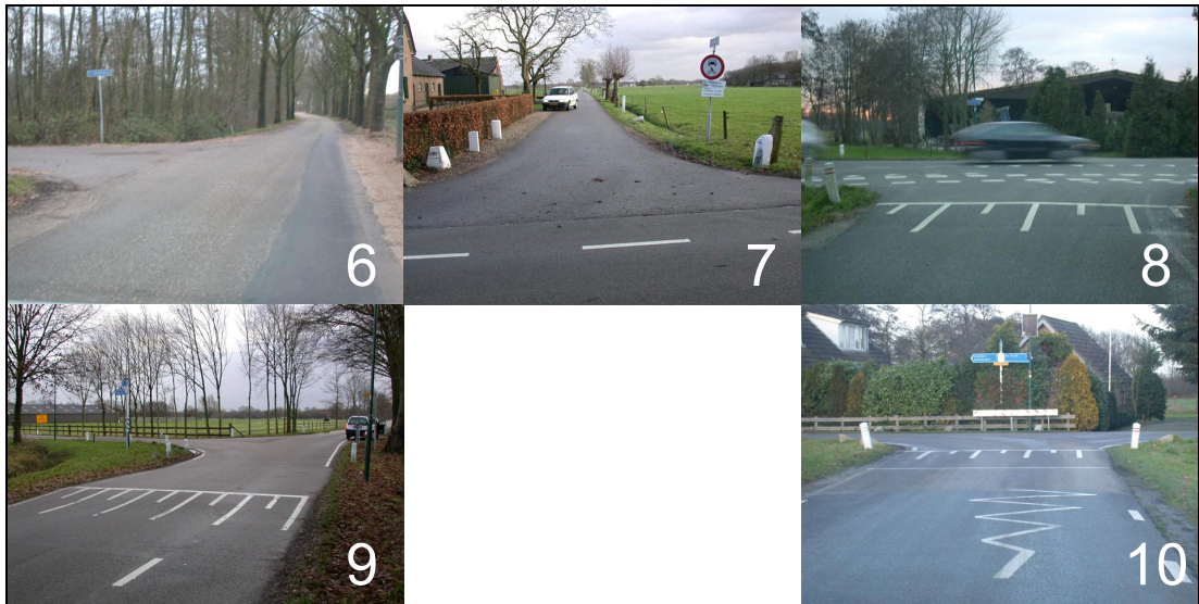
Afbeelding 4.4. Voorbeelden van kruisingen in Leusden (foto's 6-7: geen snelheidsreductie; foto 8: plateau met voorrangregeling; foto's 9-10: plateaus met wegwijzer).
