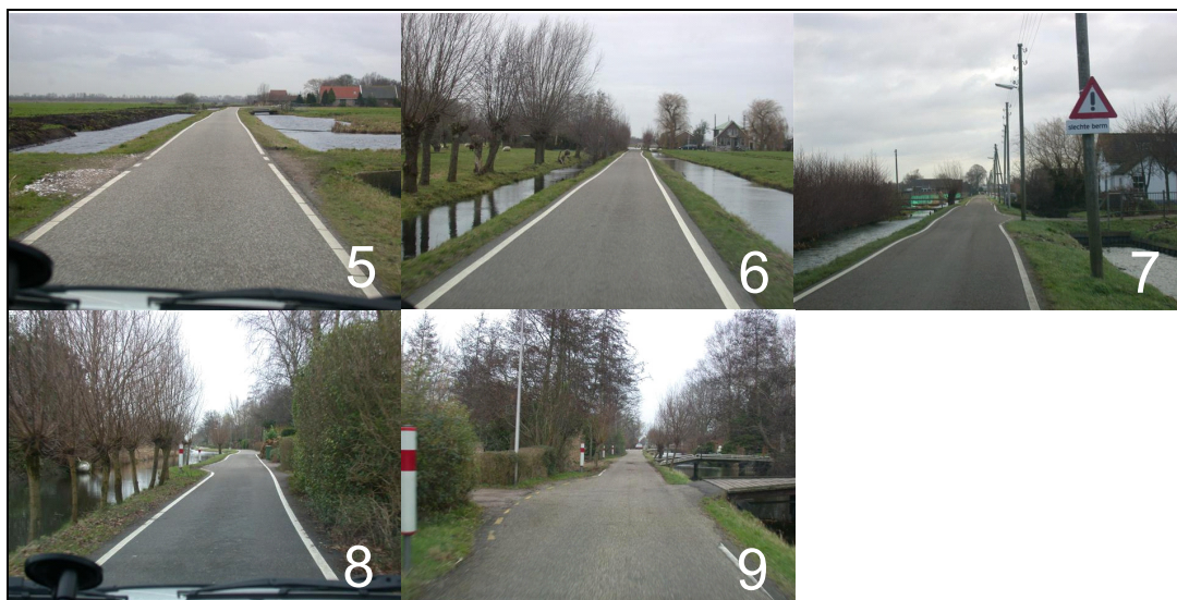
Afbeelding 4.4. Voorbeelden van niet juist toegepaste kantmarkering op erftoegangswegen in gemeente Reeuwijk (foto 9: slordige/verouderde markering).
