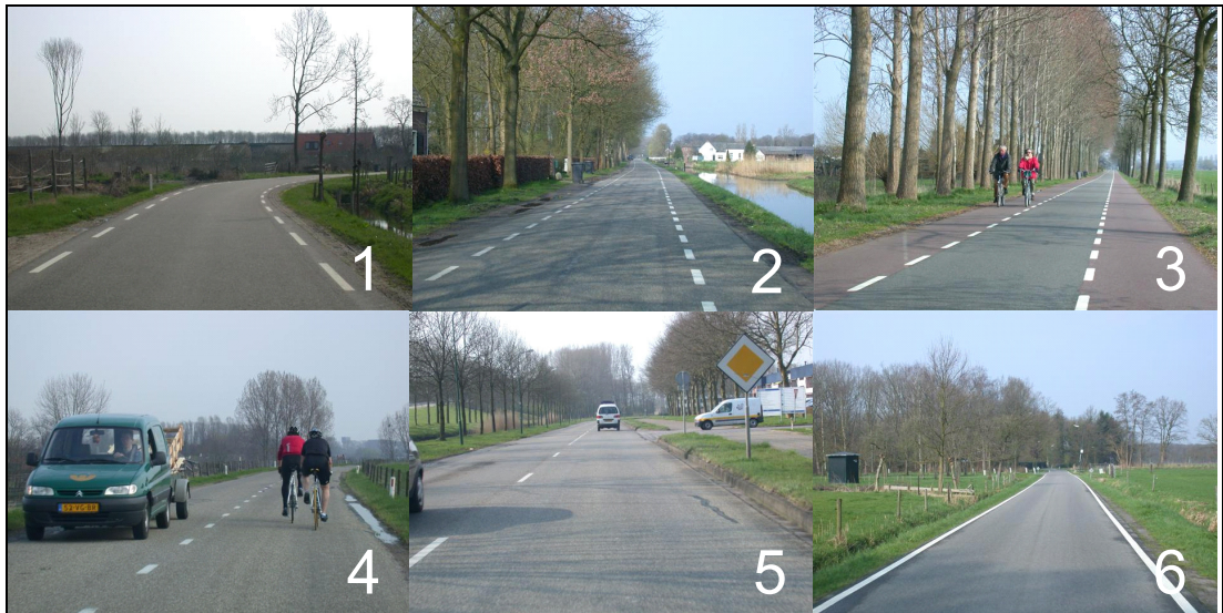
Afbeelding 4.7. Voorbeelden van een juiste markering (foto's 1-3) en onjuist uitgevoerde markering (foto's 4-6) van erftoegangswegen buiten de bebouwde kom in Wijk bij Duurstede.
