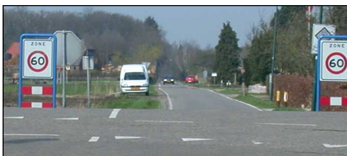
Afbeelding 4.6. Brede Zone 60-poort en doorgetrokken kantmarkering op Gooijerdijk na kruispunt met gebieds-ontsluitende weg N227.
