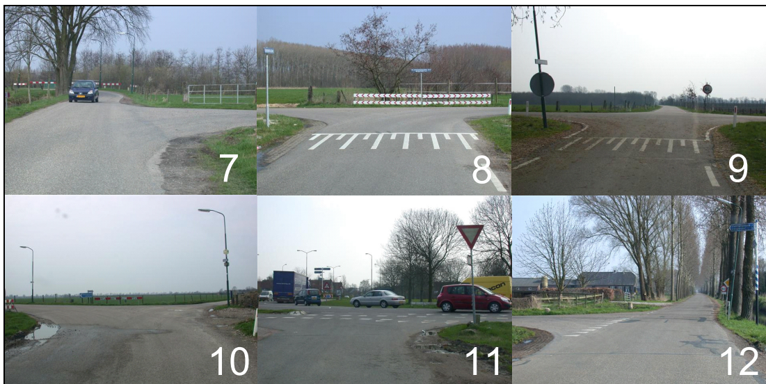
Afbeelding 4.8. Voorbeelden van kruispunten binnen Zone 60 in Wijk bij Duurstede (boven foto 7: voorrang gelijkwaardig maar geen snelheidsreductie bij overzichtelijke T-kruising; foto 8-9: plateaus; onder foto 10: geen snelheidsreductie bij onoverzichtelijke kruising in bocht en foto's 11-12: voorangsregeling)
