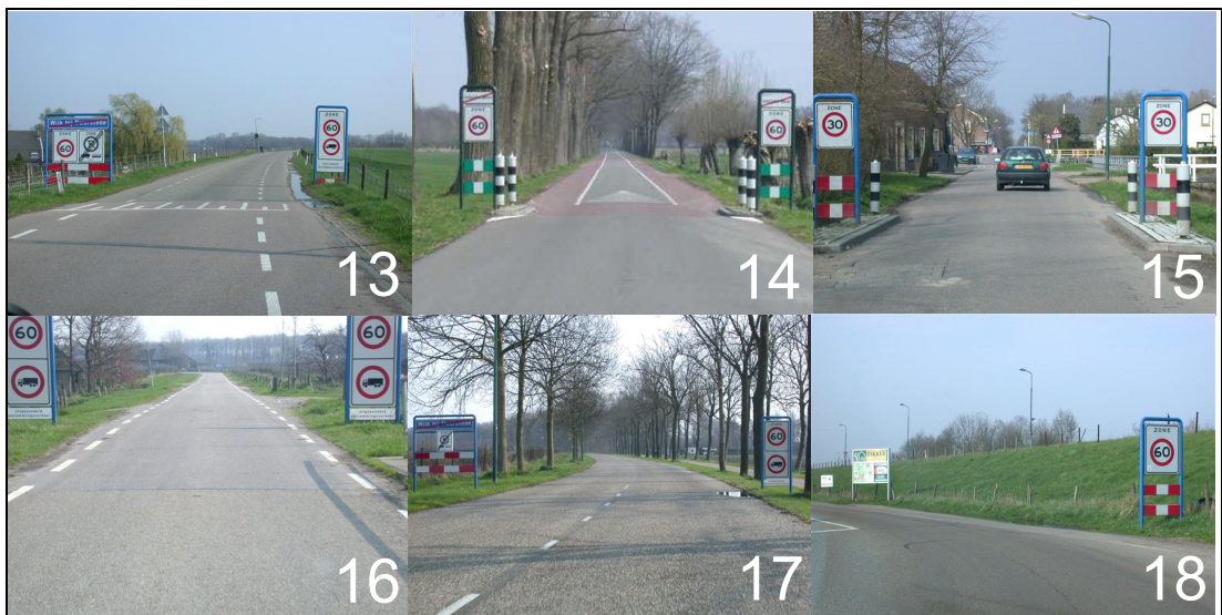
Afbeelding 4.10. Voorbeelden van een juiste (boven) en onjuiste (onder) uitvoering van een poort bij een Zone 60-overgang in Wijk bij Duurstede. Foto's 13-15: sober en redelijk uniform ingerichte poorten; foto's 16-18: geen verschil in wegkenmerken voor en na de poort (foto's 17-18 bovendien te breed en onjuiste asmarkering.)
