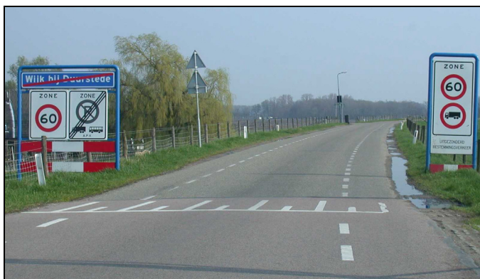
Afbeelding 4.4. Zone 60-poort na kruispuntplateau op Rijndijk.
