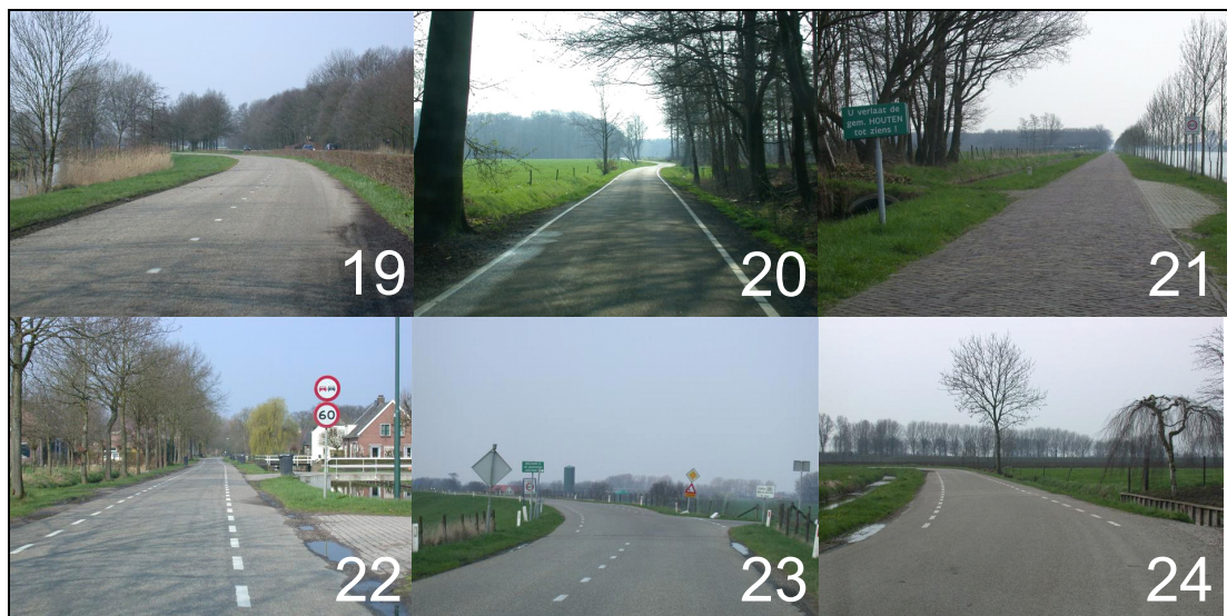
Afbeelding 4.11. Voorbeelden van gemeentegrensovergangen aan de rand van een Zone 60 in Wijk bij Duurstede. Foto's 19-22: geen discontinuïteit. Foto's 23-24 tonen een kleine discontinuïteit: na de grensovergang is wel juiste kantmarkering toegepast.
