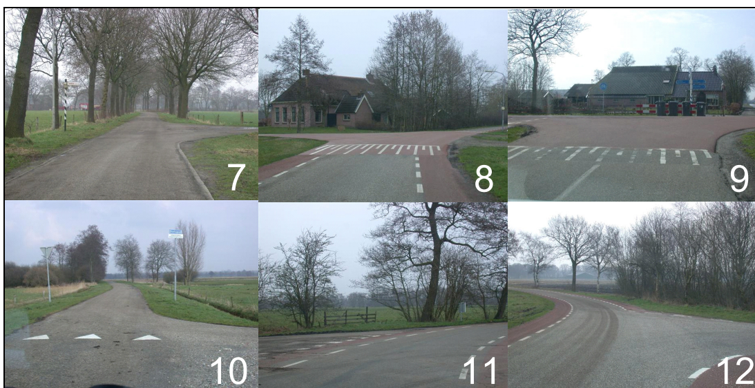
Afbeelding 4.8. Voorbeelden van kruisingen in Marum (foto 7: voorrang gelijkwaardig maar geen snelheidsreductie; foto 8-9: plateaus; foto's 10-11: voorrangsregeling; en foto's 11-12: doorlopende kantmarkering op kruispuntvlak).
