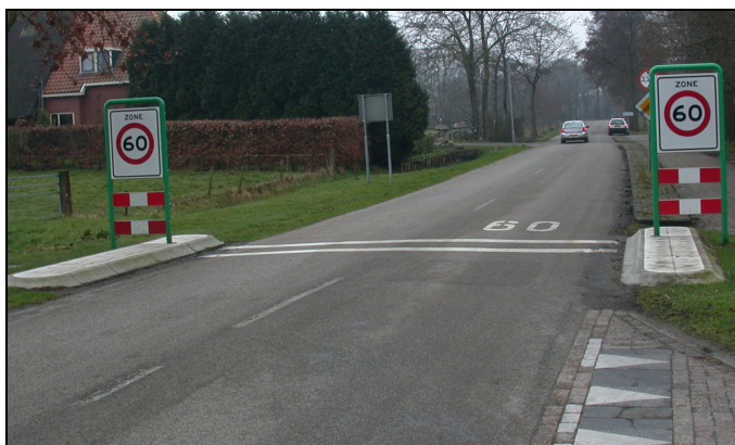
Afbeelding 4.3. De Haarsterweg is nog niet juist ingericht: wel een Zone 60-poort maar (oude) asmarkering in plaats van kantmarkering.
