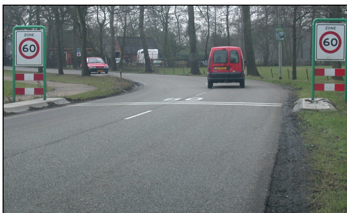
Afbeelding 4.5. Boerakkerweg is nog niet juist ingericht: wel een Zone 60-poort maar asmarkering in plaats van kantmarkering.
