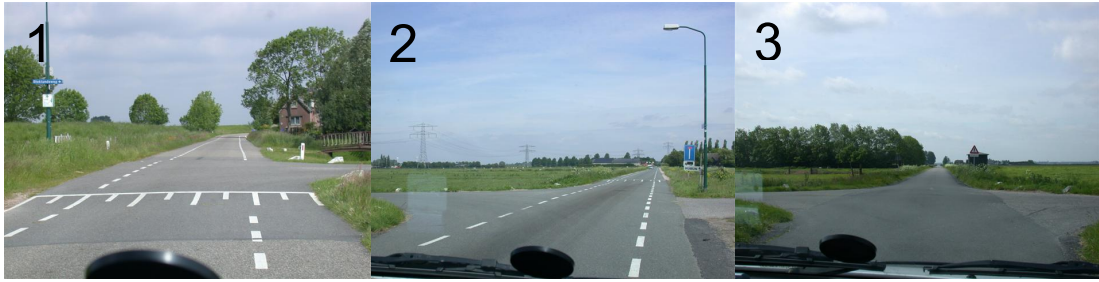
Afbeelding 4.8. Verschillende inrichtingen van kruispunten in Bunschoten: 1) Kruispuntplateau (Eemdijk-Bloklandseweg); 2) Gelijkwaardige T-kruispunt met doorlopende kantmarkering (Groeneweg-Zuidwenk); 3) Gelijkwaardige 4-takskruispunt (Fokjesweg-Frans Jacobsweg).
