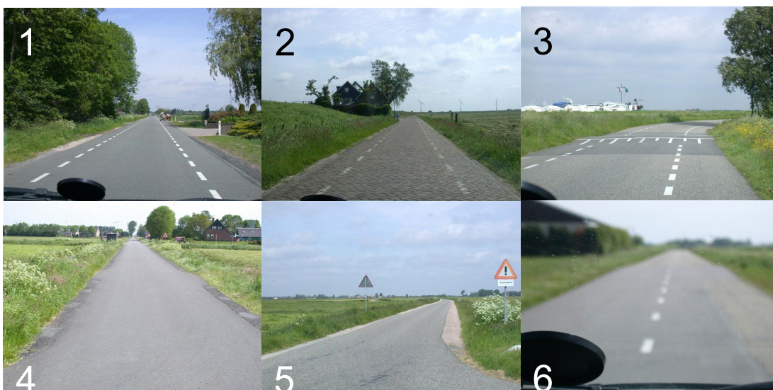
Afbeelding 4.7. Verschillende soorten wegvakken in Bunschoten: 1) rijloper met kantstroken (Zevenhuizerstraat); 2) klinkerweg met kantstrook (Westdijk); 3) rijloper met kantstroken en drempel (Eemdijk); 4) smalle weg zonder kantmarkering en verharde bermen (Fokjesweg); 5) smalle weg zonder kantmarkering en semiverharde bermen (Frans Jacobsweg); 6) foute asmarkering (Zuidwenk).
