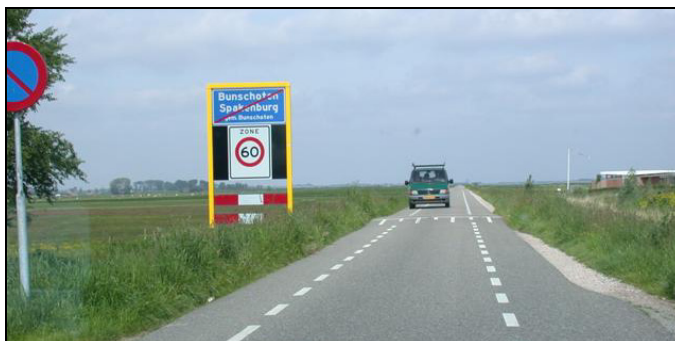
Afbeelding 4.3. Enkel Zone 60-portaal in de berm van de Westdijk (Gebied 1).
