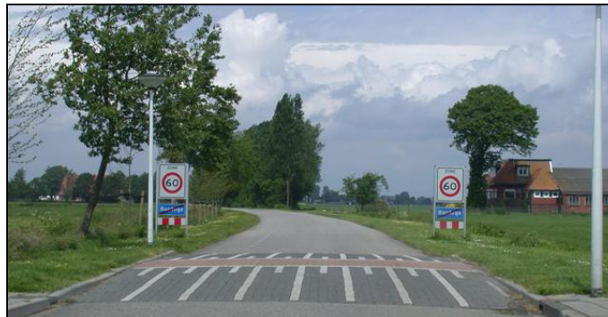
Afbeelding 4.5. Zoneovergang van 30 naar 60 km/uur in de Middenweg (midden) op de grens van de bebouwde kom van Bantega. De poort is uitgevoerd met een dubbel portaal en een drempel. De overgang van grasberm naar aanliggend trottoir ondersteunt het verschil in wegbeeld (landelijk vs. bebouwd; Gebied 3).
