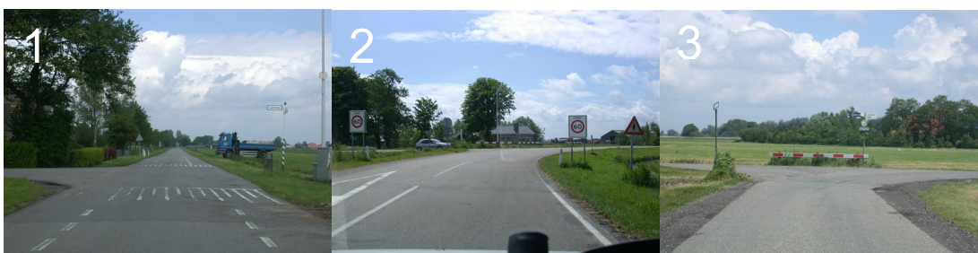
Afbeelding 4.7. Verschillende inrichtingen van T-kruisingen in Lemsterland: 1) Kruispuntplateau (Middenweg-Otterweg); 2) Voorrangskruising (Buren), niet DV; 3) Gelijkwaardige kruising (Grietenijdk-Schoterdijk).
