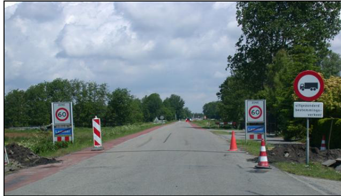
Abbeelding 4.4. Sobere Zone 60-poort met portalen aan beide zijden en rode suggestiestroken op de Straatweg (Gebied 2a).
