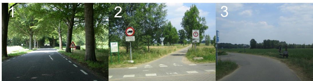
Afbeelding 4.7. Verschillende inrichtingen van kruispunten in Roerdalen: 1) 4-takskruispunt met voorrangregeling (Melickerweg); 2) T-kruispunt met fietspad en voorrangregeling (Molenbergweg); 3) Gelijkwaardig T-kruispunt (Herkenboscherweg); alle zonder snelheidsremmende maatregelen.
