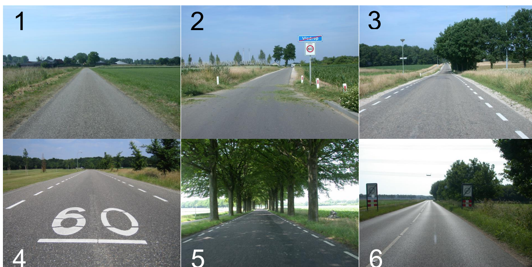
Afbeelding 4.6. Verschillende soorten wegvakken in Roerdalen: 1) brede obstakelvrije zone (Kerkenbergweg); 2) smalle weg zonder kantmarkering (Holsterweg); 3) smalle kantstrook (Bergerweg); 4) brede kantstrook (Schaapsweg); 5) brede weg met te smalle kantstrook (Melickerweg); 6) foute, oude as- en geen kantmarkering (Molenbergweg).
