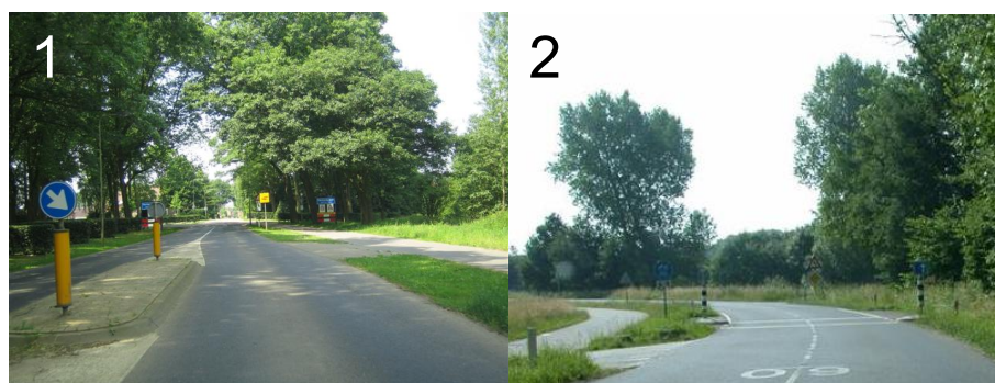
Afbeelding 4.10. Maatregelen die snelheidsverlaging beogen, zoals gebruikt in Roerdalen: 1) Asverbreding, 2) Optische versmalling door prefab-elementen met paaltjes in de berm, beide op de Molenbergweg.
