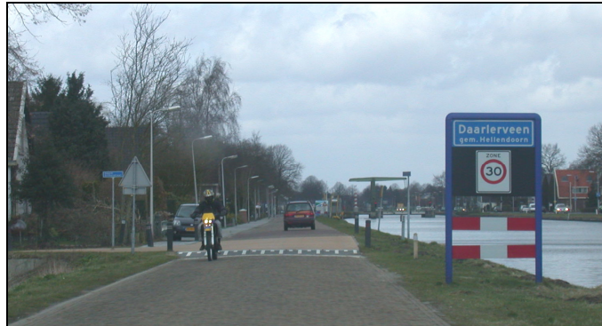
Afbeelding 4.6. De categoriegrenzen met de Zone 30 van de bebouwde kom van Daarlerveen zijn redelijk sober uitgevoerd.
