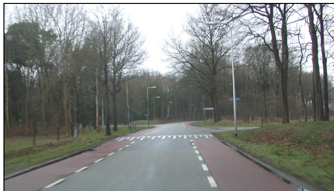
Afbeelding 4.3. Op de Poggenbeltweg is in 2001 een pilotstudie uitgevoerd door de SWOV, naar de effecten van rode suggestiestroken en plateaus op het verkeersgedrag (Van der Kooi, 2001).
