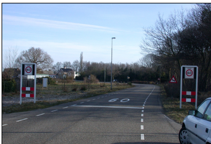
Afbeelding 4.3. De Onze Lieve Vrouwestraat is voorzien van suggestiestroken en is in de voorrang. De overgang tussen de Zone 60 en 80 km/uur is aangegeven met een dubbele poortconstructie, een dubbele dwarsstreep en op het wegdek.
