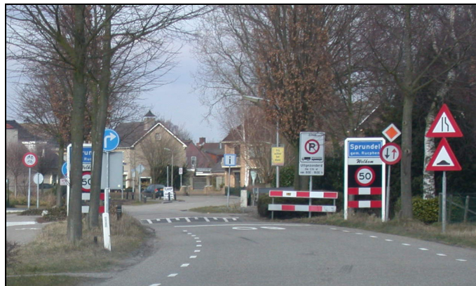
Afbeelding 4.5. De overgang met de bebouwde kom van Sprundel is goed ingericht. Het is de vraag of een weggebruiker door de hoeveelheid borden begrijpt wat er allemaal van hem verwacht wordt.
