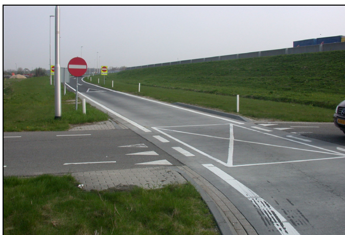
Afbeelding 4.3. De afrit 'Zeeland' van de A50 wordt op het einde gekruist door een Zone 60-weg, dit is niet conform Duurzaam Veilig.
