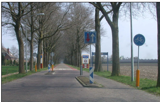
Afbeelding 4.5. Op de Rogstraat is gebruikgemaakt van ov-vriendelijke snelheidsremmers bij de overgang tussen Zone 60 en Zone 30.
