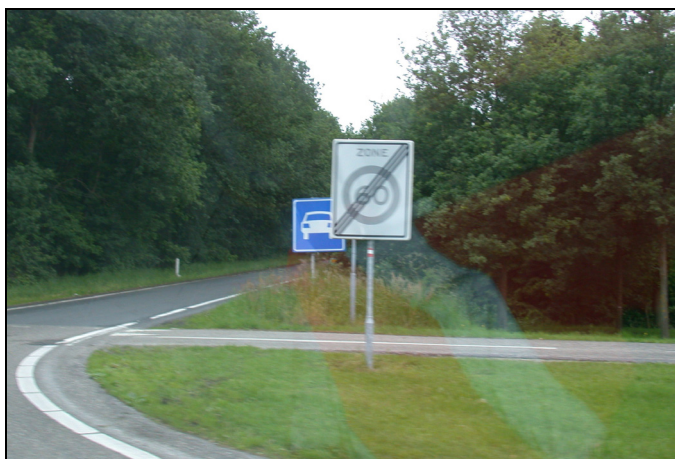
Afbeelding 4.3. De directe aansluiting van de Zone 60 op de nationale stroomweg N36 is opvallend, dit is niet conform Duurzaam Veilig.
