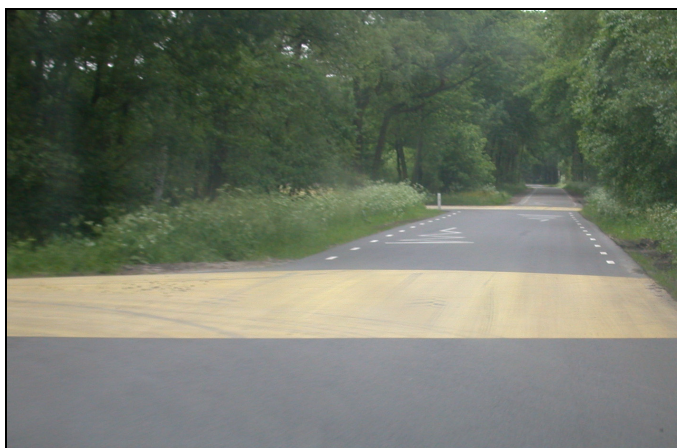
Afbeelding 4.5. Het merendeel van de kruispunten is gelijkwaardig en is niet voorzien van snelheidsremmende maatregelen. Op de Hessenweg West zijn op twee kruispunten alternatieve snelheidsremmende en attentieverhogende kruispuntplateaus aangelegd.
