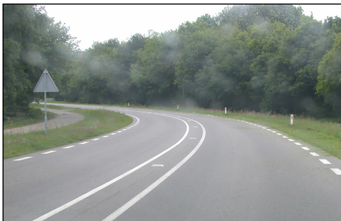
Afbeelding 4.6. Op de Zwolseweg en Vlisterenseweg hebben in het verleden veel ongevallen met motoren plaatsgevonden. Daarom is heeft de gemeente ervoor gekozen dubbele asmarkering en reflectoren vlak voor en na een boch aan te brengen. Verder is er een vrijliggend fietspad en is het een voorrangsweg. Dit past niet bij een erftoegangsweg volgens Duurzaam Veilig.
