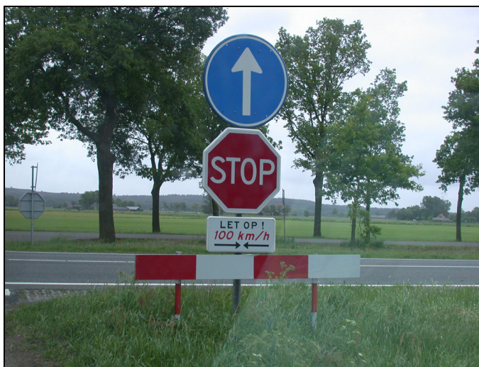
Afbeelding 4.7. De gelijkvloerse kruispunten met de provinciale autoweg N348 zijn levensgevaarlijk. Alhoewel er geen directe aansluiting is, wordt verkeer dat met 100 km/uur over een stroomweg rijdt, gelijkvloers gekruist. Dit is niet duurzaam veilig
