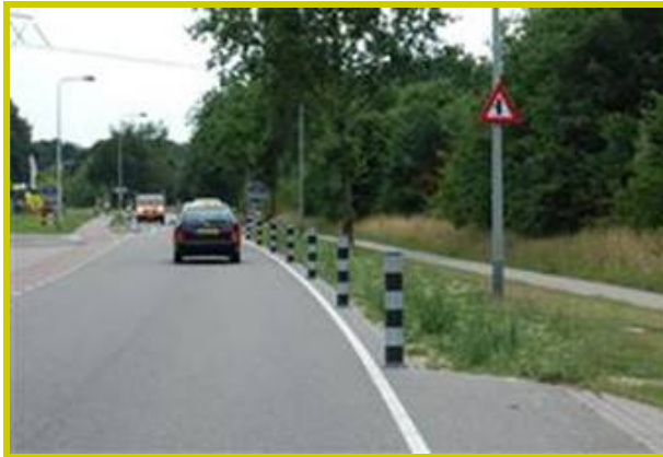
Afbeelding 3: Eén van de infrastructurele maatregelen voorgesteld voor de Heerstraat: het plaatsen van paaltjes (SKOM, 2009).
