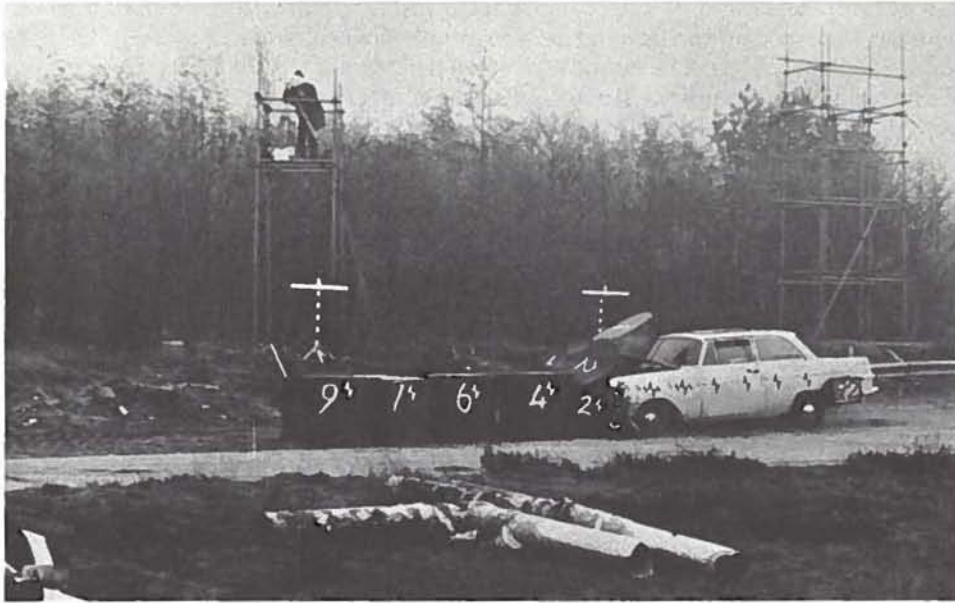
Afbeelding 17: Begin van de botsing met een obstakelbeveliger van met zand gevulde pertinax vaten, beproefd door de SWOV
