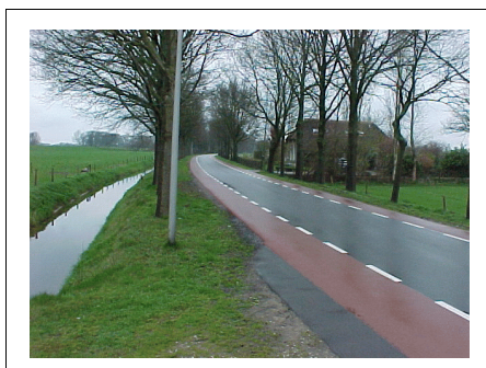
Afbeelding B5.3. Drempel verwijderd in de nasituatie.
