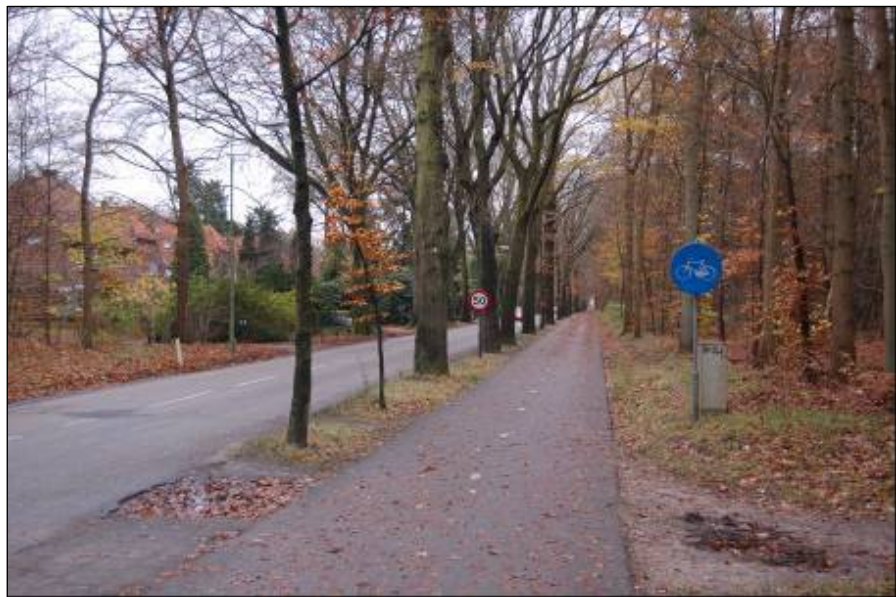
Afbeelding 2.3. Krakelingweg in zuidelijke richting, met links uitritten en met rechts het fietspad.
