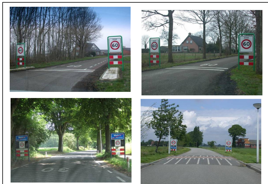
Afbeelding B.4. Voorbeelden van poortconstructies buiten de bebouwde kom (boven) en van binnen naar buiten de bebouwde kom (onder).
