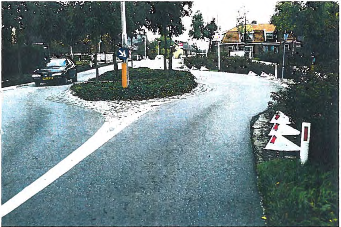
Afbeelding 5. Asverschuiving
