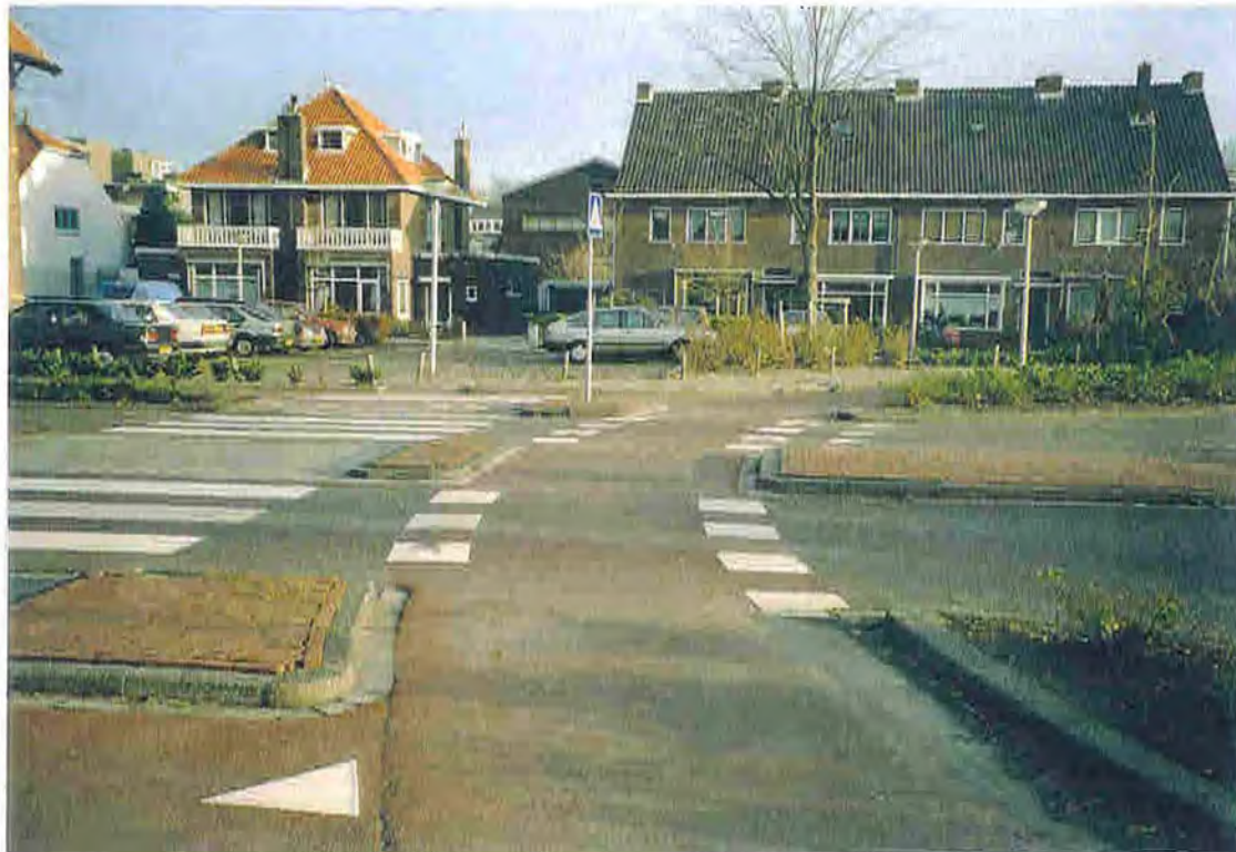
Foto B3.3. Uitvoering fietspaden en zebra's bij rotonde Naaldwijk.
