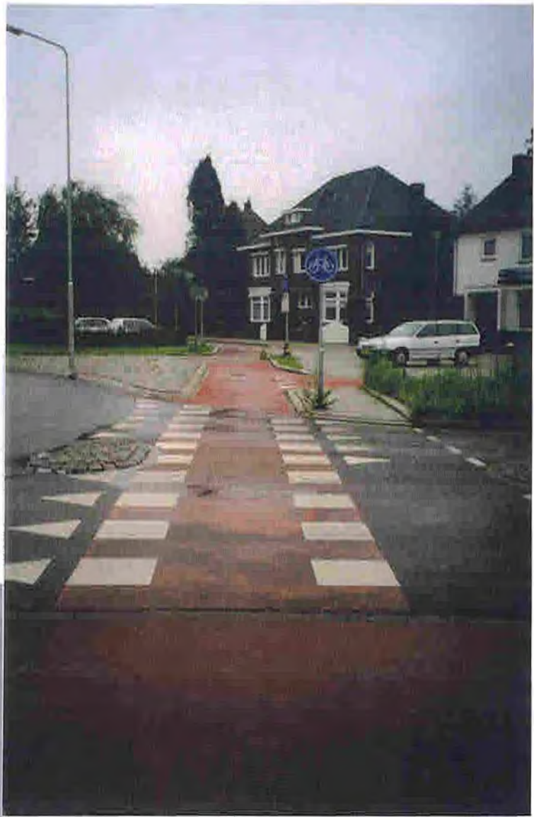
Foto B1.3. Fietsoversteek dicht op het plein, rotonde Venray.
