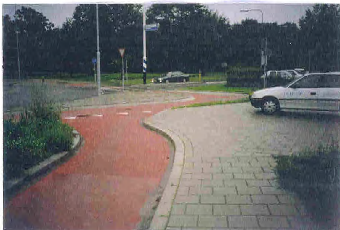
Foto B1.2. Rode fietspaden en afschuining, rotonde Venray.
