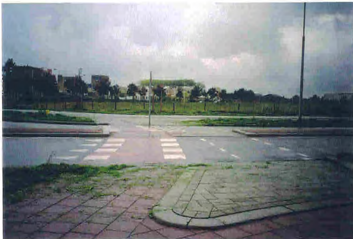
Foto B2.3. Toepassing verschillende materialen voor fietspad, rotonde Roermond.
