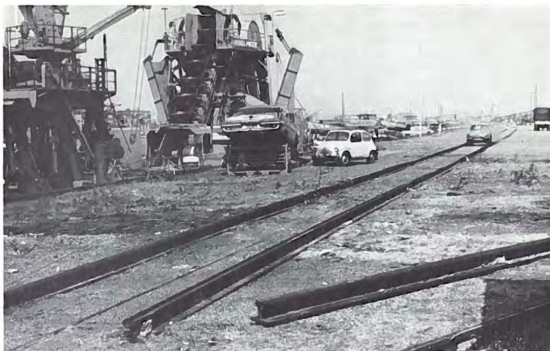
Afbeelding 6. De aandrijving van de proefvoertuigen vond plaats met behulp van een lierinstallatie, de geleiding via rails.
