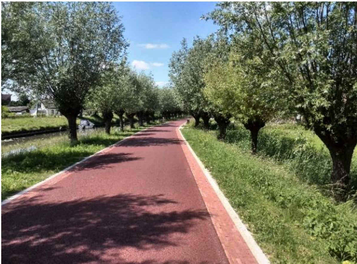
Figuur 1 Fietsstraat buiten de bebouwde kom in Utrecht (Zandweg)
