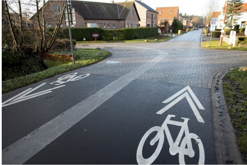
Frans Raatsstraat-René Willemestraat-Warandalei te Kalmthout, detail Frans Raatsstraat na herinrichting als fietsstraat
