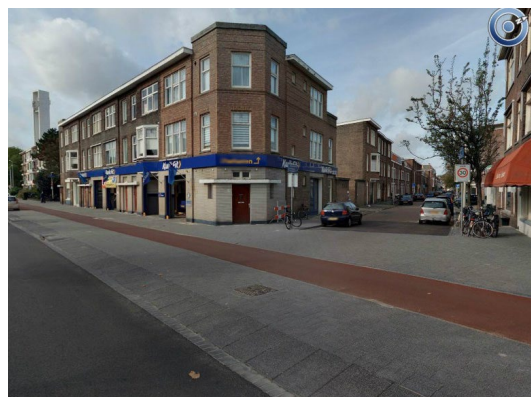
Erftoegangsweg eindigend in uitritconstructie (Bron: CycloMedia)
