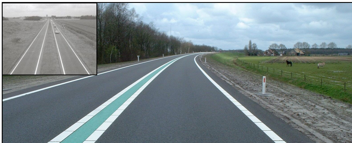
Figuur 2.9 Twee typen regionale stroomwegen [www.crow.nl/wegontwerp]
