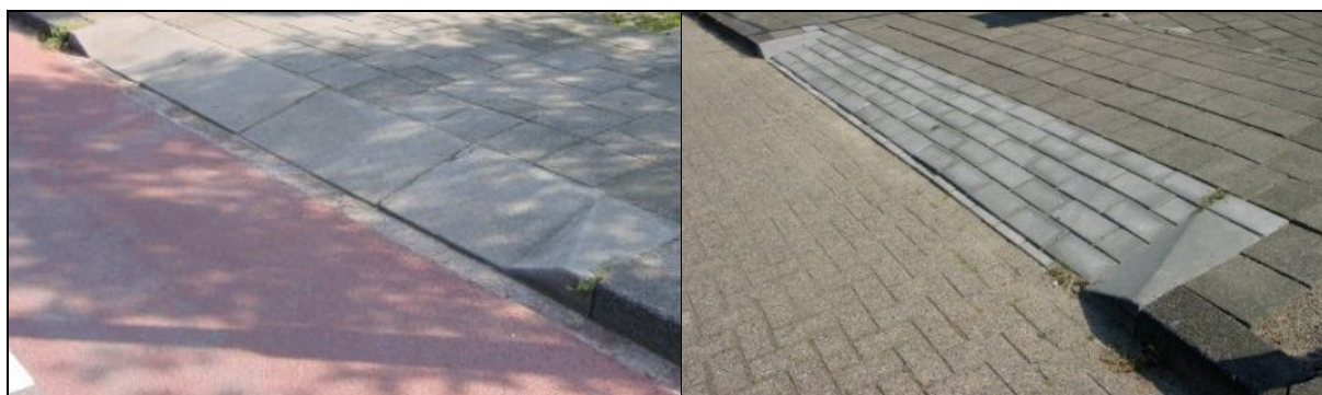
Figuur 2.43 Uitritconstructie uitgevoerd met blokken (links) of met hoekelementen (rechts) [ www.crow.nl/asvv ]
