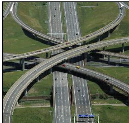
Figuur 2.17 Voorbeeld van een ster-knooppunt: Prins Clausplein [www.aerophoto-schiphol.nl]
