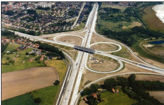
Figuur 2.19 Aanleg (2004) van verkeerswisselaar bij Zelzate tussen N49 (Antwerpen-Knokke) en R4 vanwege ombouw N49 tot autosnelweg E34
