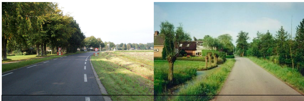
Figuur 2.10 Twee typen erftoegangswegen: links ETW type I en rechts ETW type II [www.crow.nl/wegontwerp]
