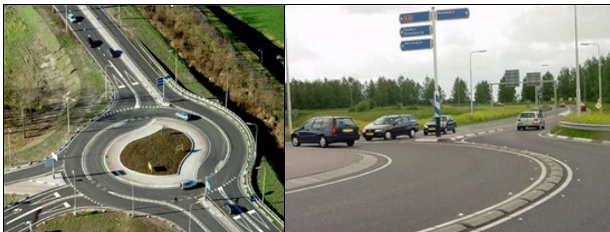
Figuur 2.31 Turborotonde N459/A12 bij Reeuwijk, met rechts de rijstrookscheiding. [www.crow.nl/duurzaamveilig]
