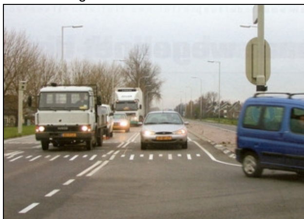
Figuur 2.36 Conflictvrij geregelde verkeerslichten met snelheidsremmende, ongevalkans verlagende voorziening. [www.crow.nl/duurzaamveilig] "Op kruispunten met conflictvrije verkeerslichten gebeuren tot dertig procent minder ongevallen." [De Standaard, 03-05-2006]
