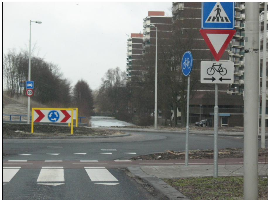
Afbeelding 3.10. Zelfde toerit B als in Afbeelding 3.9 maar dichterbij de rotonde. Slechts op korte afstand vallen de haaiantanden vóór de zebra op.
