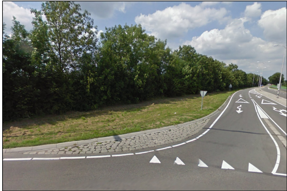
Afbeelding 3.6. Een "oksel" in basaltsteen bij de toerit van de rotonde (N207, Provincie Zuid-Holland).
