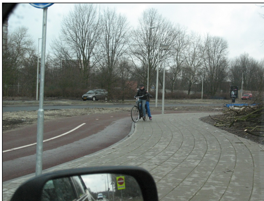
Afbeelding 3.13. Het zicht naar rechts vanuit toerit B bij de fietsoversteek. Na de bocht loopt het fietspad sterk naar beneden. Door de bocht en het hoogteverschil is het zicht op het fietspad belemmerd.
