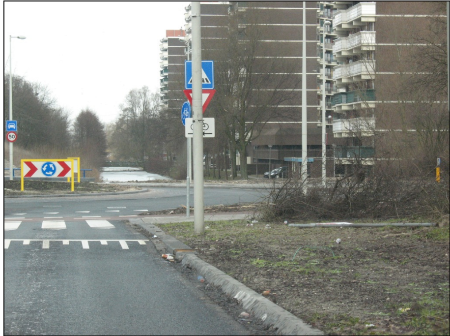
Afbeelding 3.9. De haaiantanden bij het zebrapad van toerit B zijn op grotere afstand niet opvallend; lichtmast beperkt zicht op borden.
