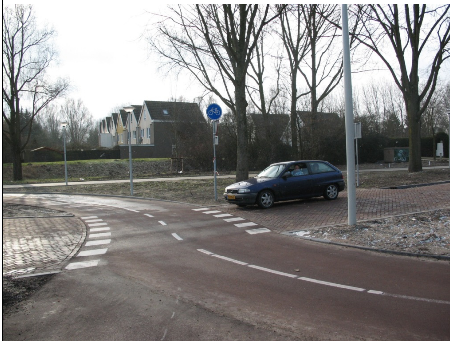
Afbeelding 3.8. Toerit A; beide foto's tonen dat de voorrangsregeling onduidelijk is doordat de haaiantanden niet goed opvallen. Dit is zeker het geval onder natte weersomstandigheden.
