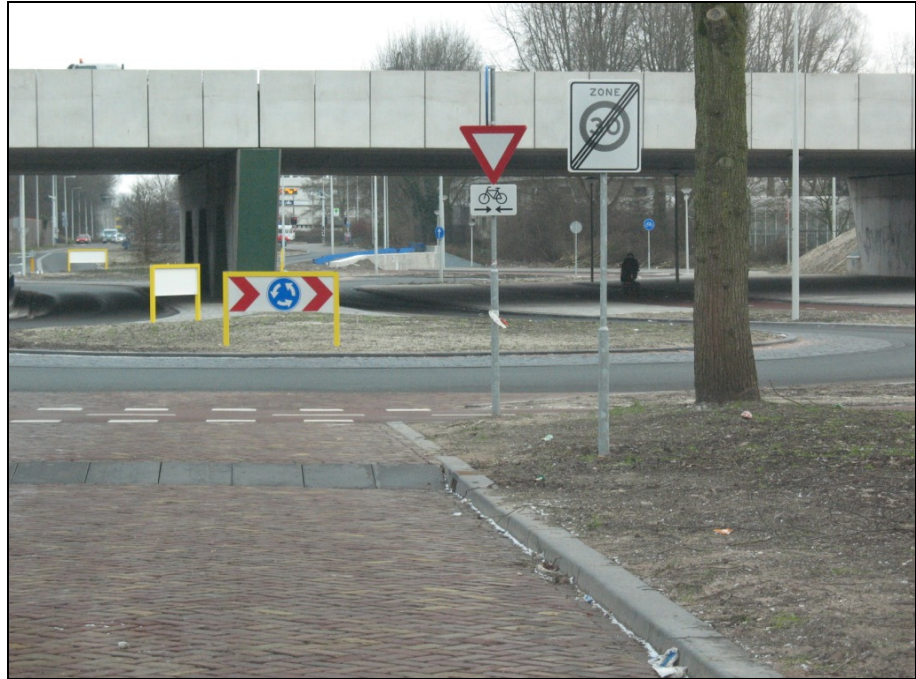
Afbeelding 3.2. Het zicht vanuit toerit A (eerste potentiële conflictpunt) met een goede haakse aansluiting waardoor de barrièrewerking van het middeneiland ten volle wordt benut.
