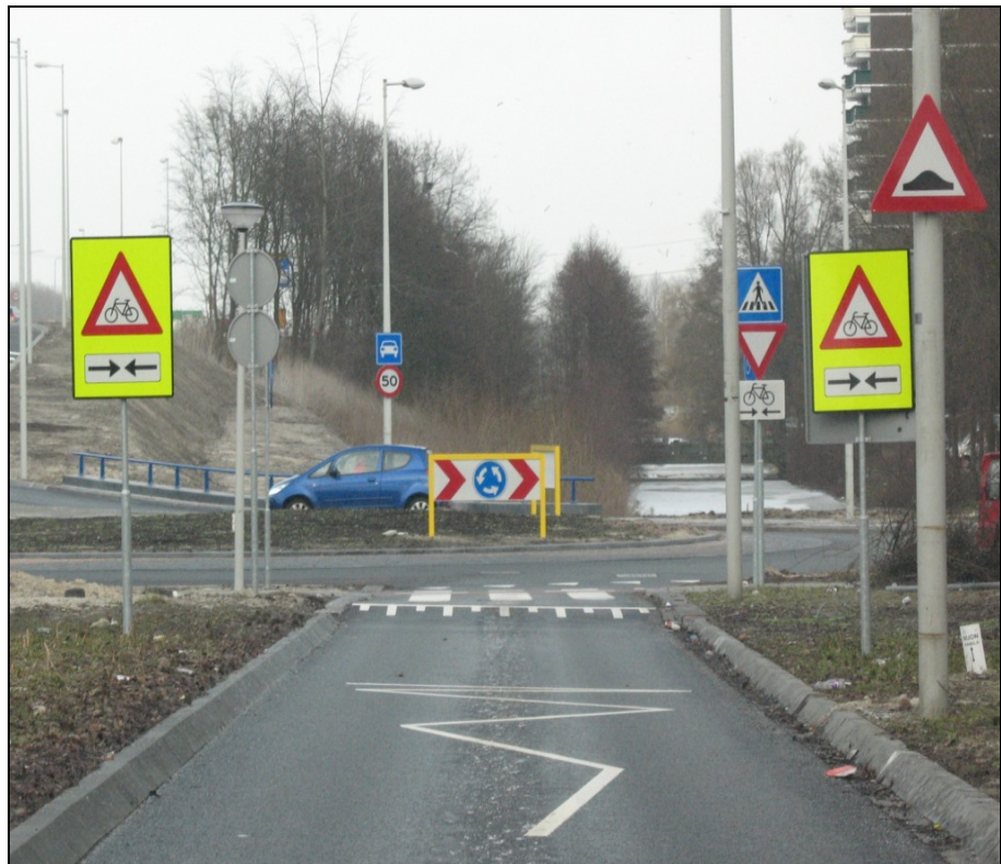
Afbeelding 3.3. Het zicht vanuit toerit B (tweede potentiële conflictpunt) met een niet-haakse aansluiting. De toerit komt niet uit op het midden van het middeneiland, maar rechts ervan waardoor er een minder goede barrièrewerking van het middeneiland uitgaat.
