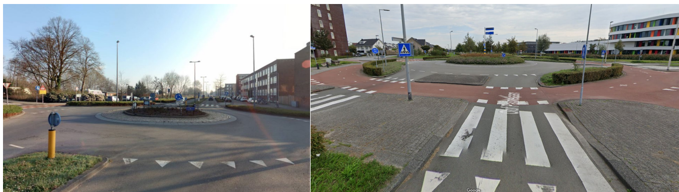
Afbeelding 3.6. Voorbeelden van een rotonde zonder en met een VOP. Bron: Google Maps, 2021.
