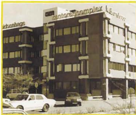
Kantoorpand aan de Duindoorn in Leidschendam
