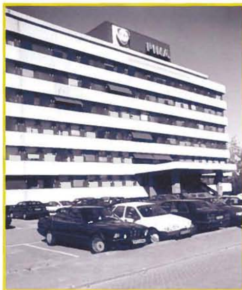
Dependance in het 'FINA-gebouw' aan de Nieuwe Havenstraat in Voorburg
