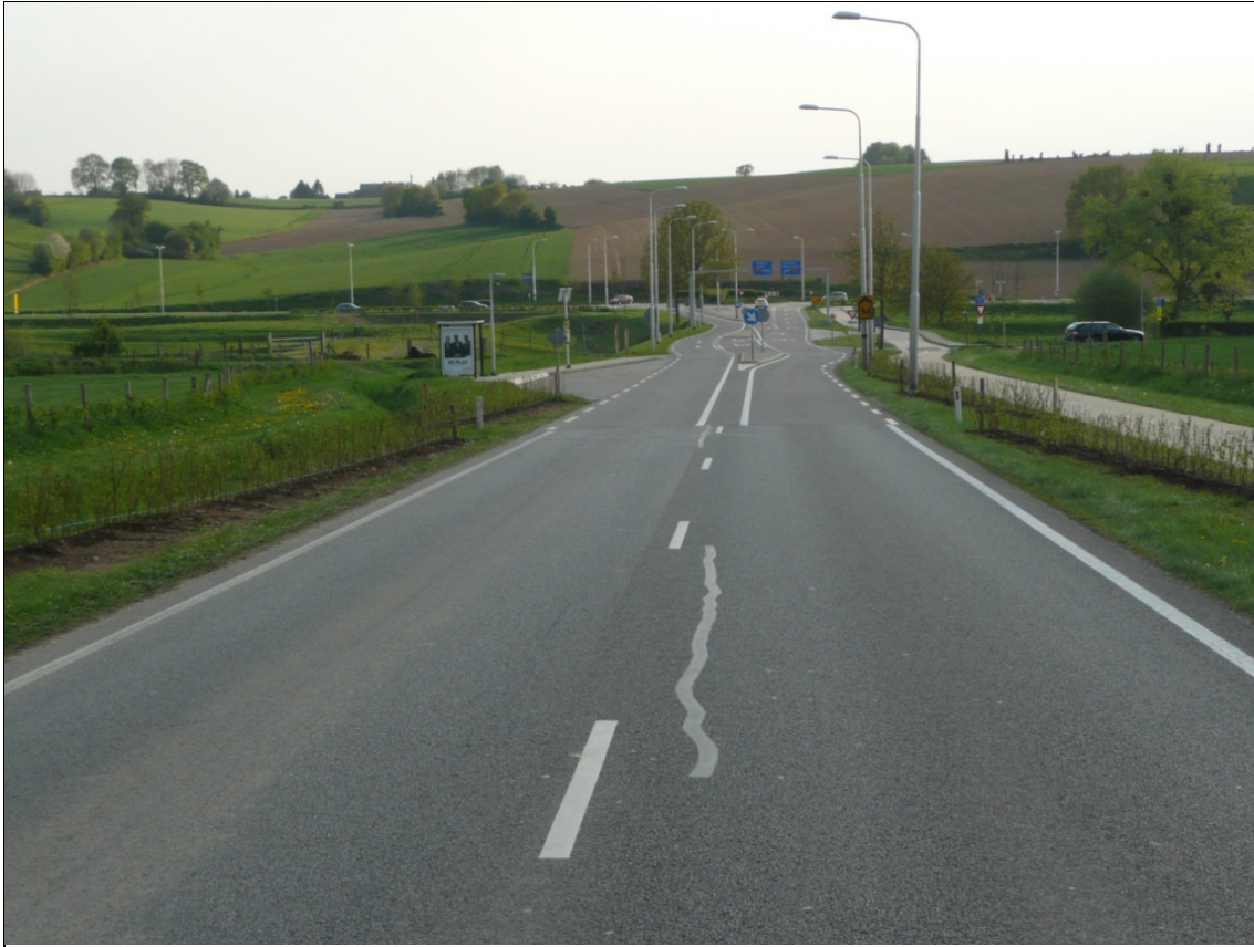
Afbeelding A.2. Aanloop van de Kolmonderstraat/Kolmonderbosweg en de N278 vanaf de N281 na het aanbrengen van de Natuurlijk Sturen-maatregelen, situatie september 2011. Door een relatief natte en koude zomer hebben de hagen echter nog niet het volume gekregen dat door de provincie wordt beoogd.
