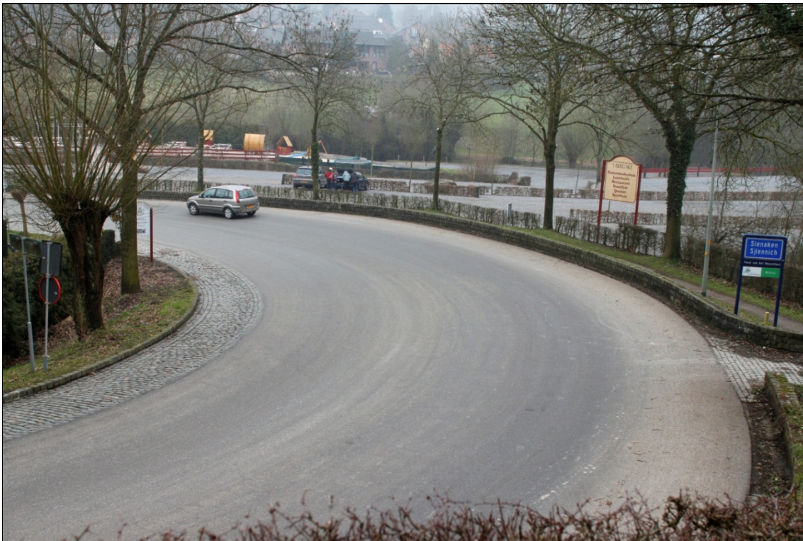
Afbeelding A.3. De scherpe bocht bij het bruggetje over de Gulp (locatie 2a) richting Hoogcruts in de voorsituatie, medio februari 2011.
